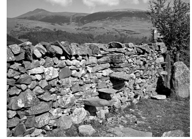
Murets de pierre à proximité de Keswick dans la région des Lacs au nord-ouest de l'Angleterre
